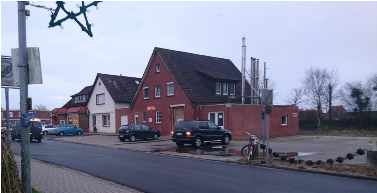
Blick von Nordosten - mit unbebauter, versiegelter Grundstücksfläche nördlich der bestehenden Bebauung
